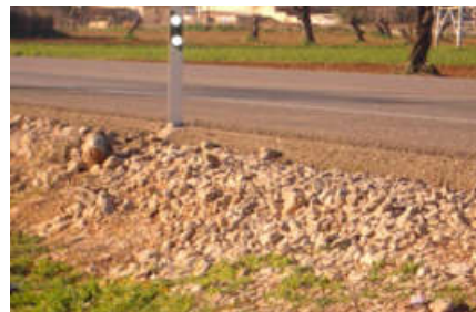
Millora de cunetes
