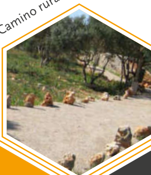
Nivelación de terreno
