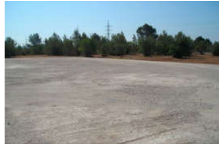
Nivelación de terreno
