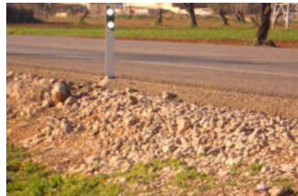
Mejora de cunetas
