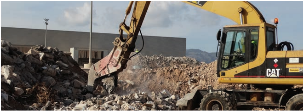
Demolició petris > 40 cm
