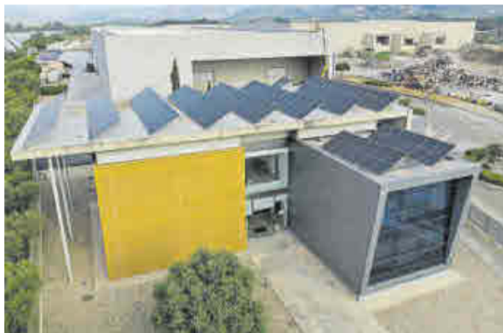
La nueva instalación fotovoltaica permite que el 50% del consumo energético en oficinas sea de generación renovable propia
