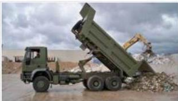
Descarga de residuos (Foto:OC COMGEBAL)
