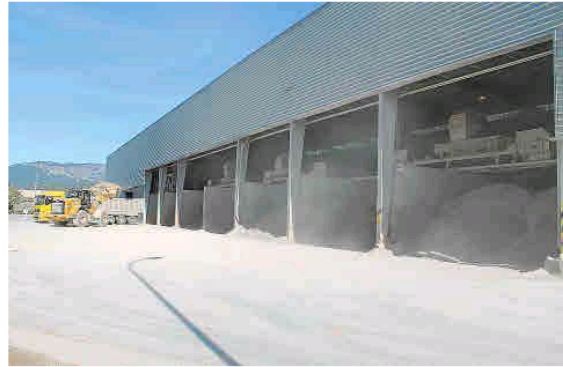
▲ Los escombros se transforman en áridos reciclados para su posterior venta.
